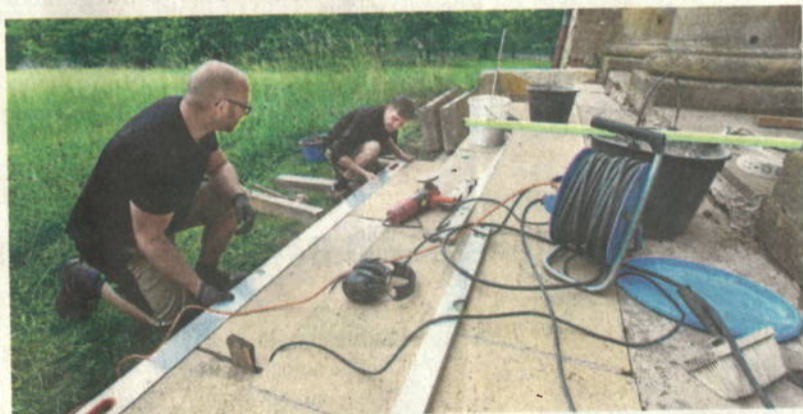
Steinmetzmeister Alexander Scholz (links) und Maurer Petre Schulz setzen die Stufen an der Kolonade zwischen Neues Schloss (hinten) und Telemann-Saal neu.
