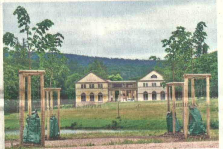
Blick über den sanierten Damm mit der neuen Lindengruppe auf dem vorgelagerten Rondell und über den See hinweg zum Schloss.
