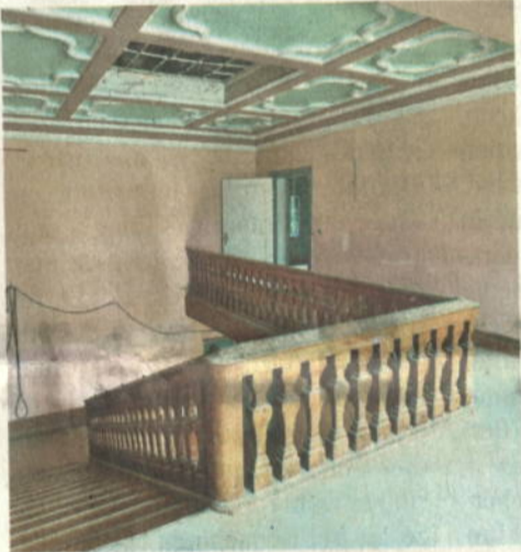
Der Treppenaufgang im sogenannten Littmannbau: Hier gibt es noch viel Arbeit.
